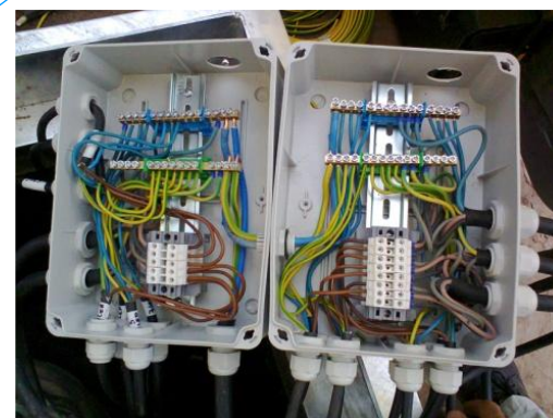
propojení kabeláže všech světelných okruhů v přípojných krabicích
