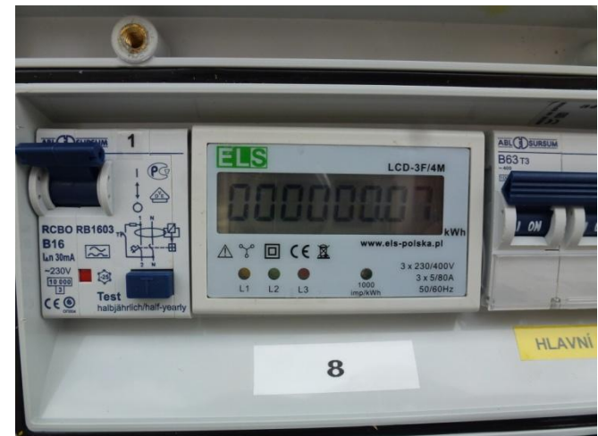
elektroměr pro podružné měření - 3 fázový
