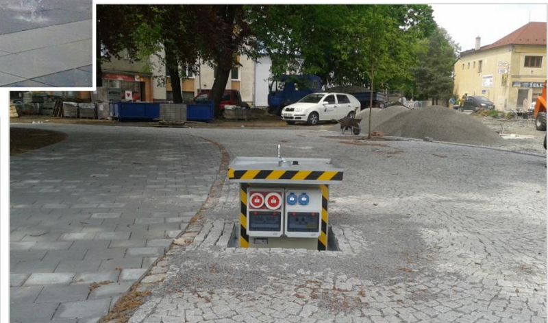
krátce po instalaci sloupku
