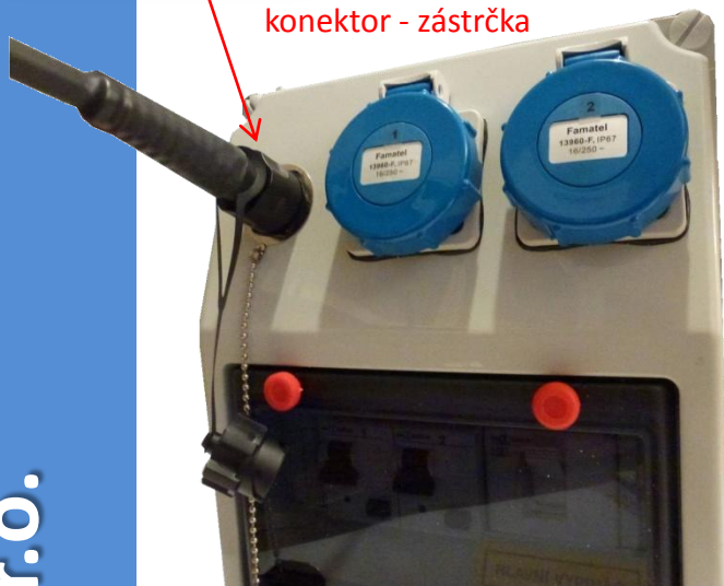
uzavřené optické propojení konektor - zástrčka
