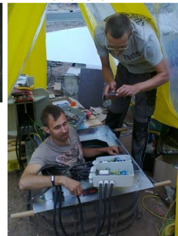
propojení kabeláže všech světelných okruhů v přípojných krabicích
