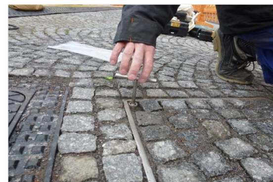
vložení přípravku pro ovládání víka
