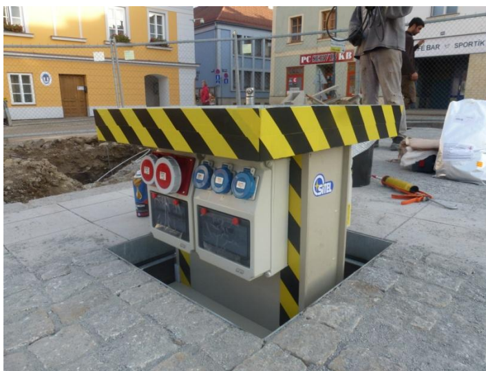
po instalaci „STAVBA“ ještě zajistí výplň víka
