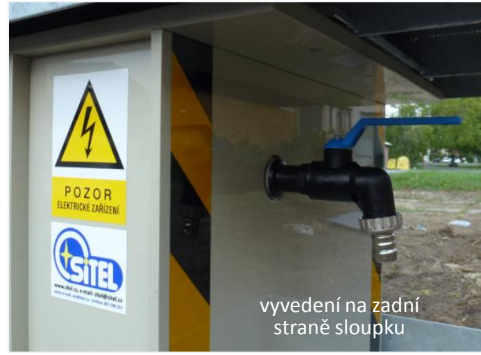
kulový mrazuvzdorný ventil ARTIC 3/4" -20°C až + 70°C
